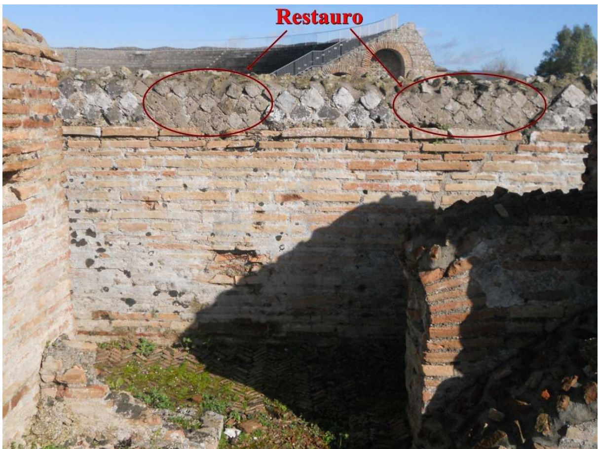
Figura 46: foto muro perimetrale Nord - facciata interna. Particolare intervento di restauro. Ninfeo Est, Minturnae.
