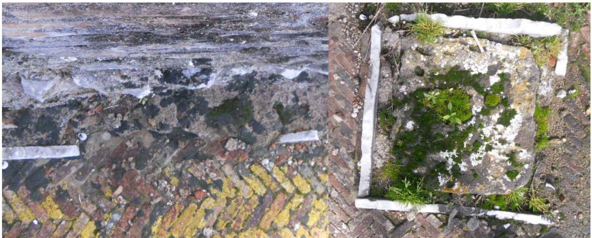
Figure 75 e 76: dettagli pavimentazione opus spicatum I fase. Ninfeo Est - Minturnae.
