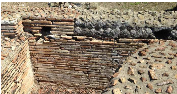
Figura 45: muro perimetrale Nord, facciata interna, dettaglio foro per l'adduzione e risega. Ninfeo Est, Minturnae.
