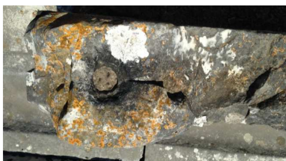
Figure 60– 61 – 62 : dettagli faccia anteriore, laterale e superiore del blocco superstite della balastra. Ninfeo Est - Minturnae.
