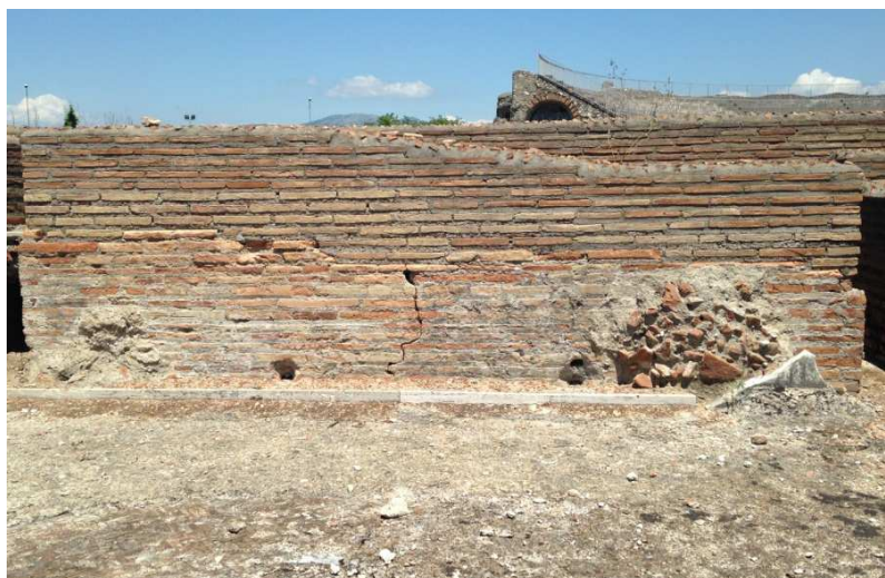
Figura 127: facciata esterna muro ad "U", dettaglio rivestimento marmoreo. Ninfeo Ovest - Minturnae.
