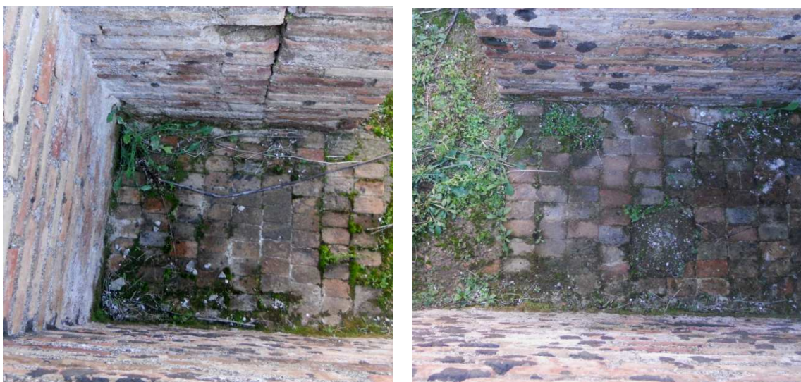
Figure 128 e 129: pavimentazione opus spicatum ambiente a pianta rettangolare, vano posteriore. Ninfeo Ovest - Minturnae.
