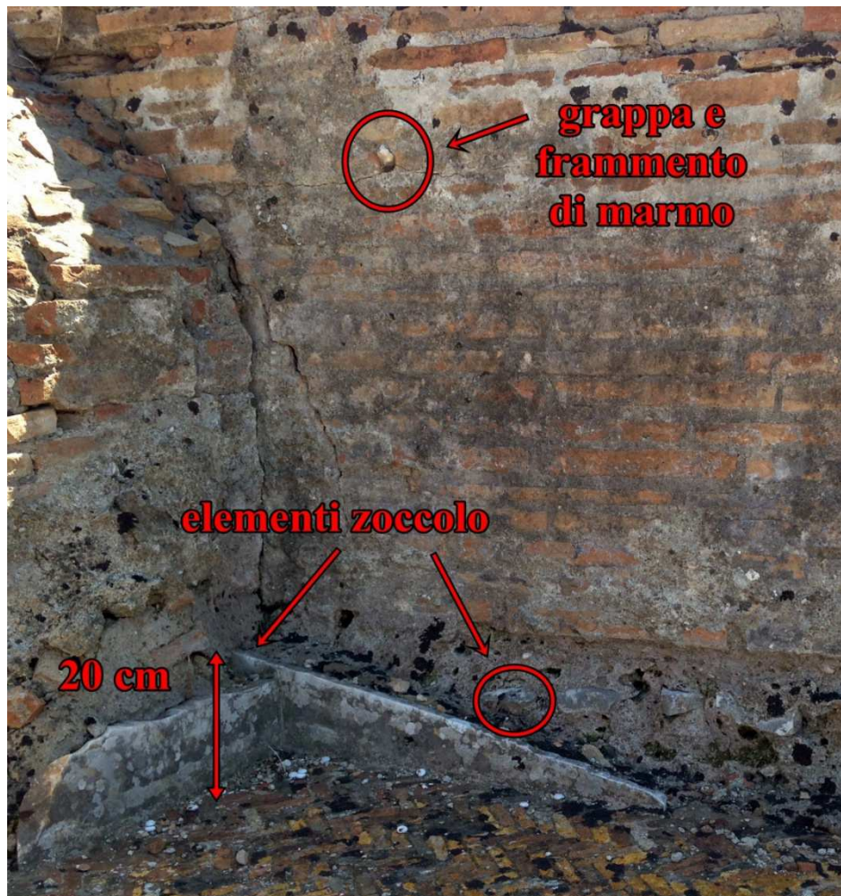
Figura 51: muro perimetrale est, dettagli zoccolo e opus sectile. Ninfeo Est - Minturnae.
