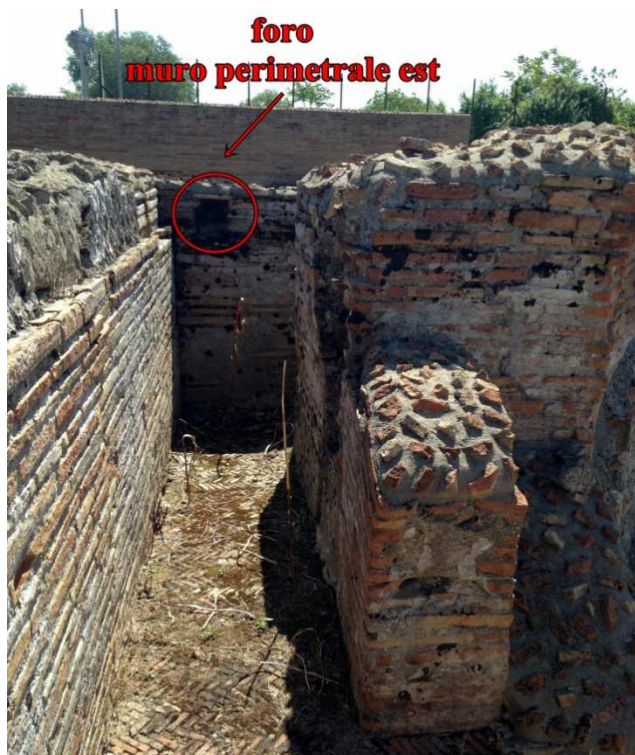
Figura 49: muro perimetrale est, dettaglio foro adduzione dell'acqua. Ninfeo Est - Minturnae.
