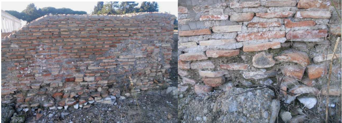
Figure 99 e 100: muro perimetrale est, facciata esterna. Ninfeo Ovest - Minturnae.
