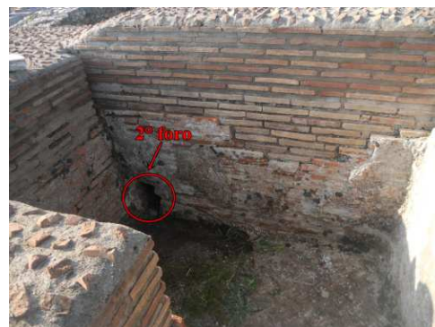
Figure 93 e 94: muro perimetrale ovest, dettagli fori per il deflusso dell'acqua. Ninfeo Ovest - Minturnae.
