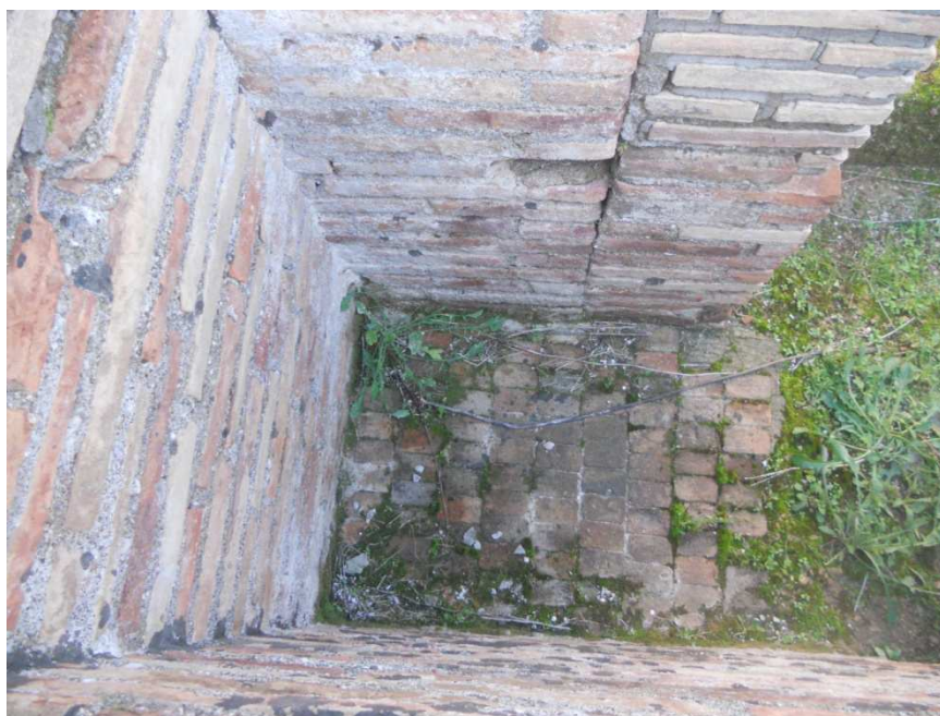
Figura 112: dettaglio pavimentazione ambiente rettangolare. Ninfeo Ovest - Minturnae.
