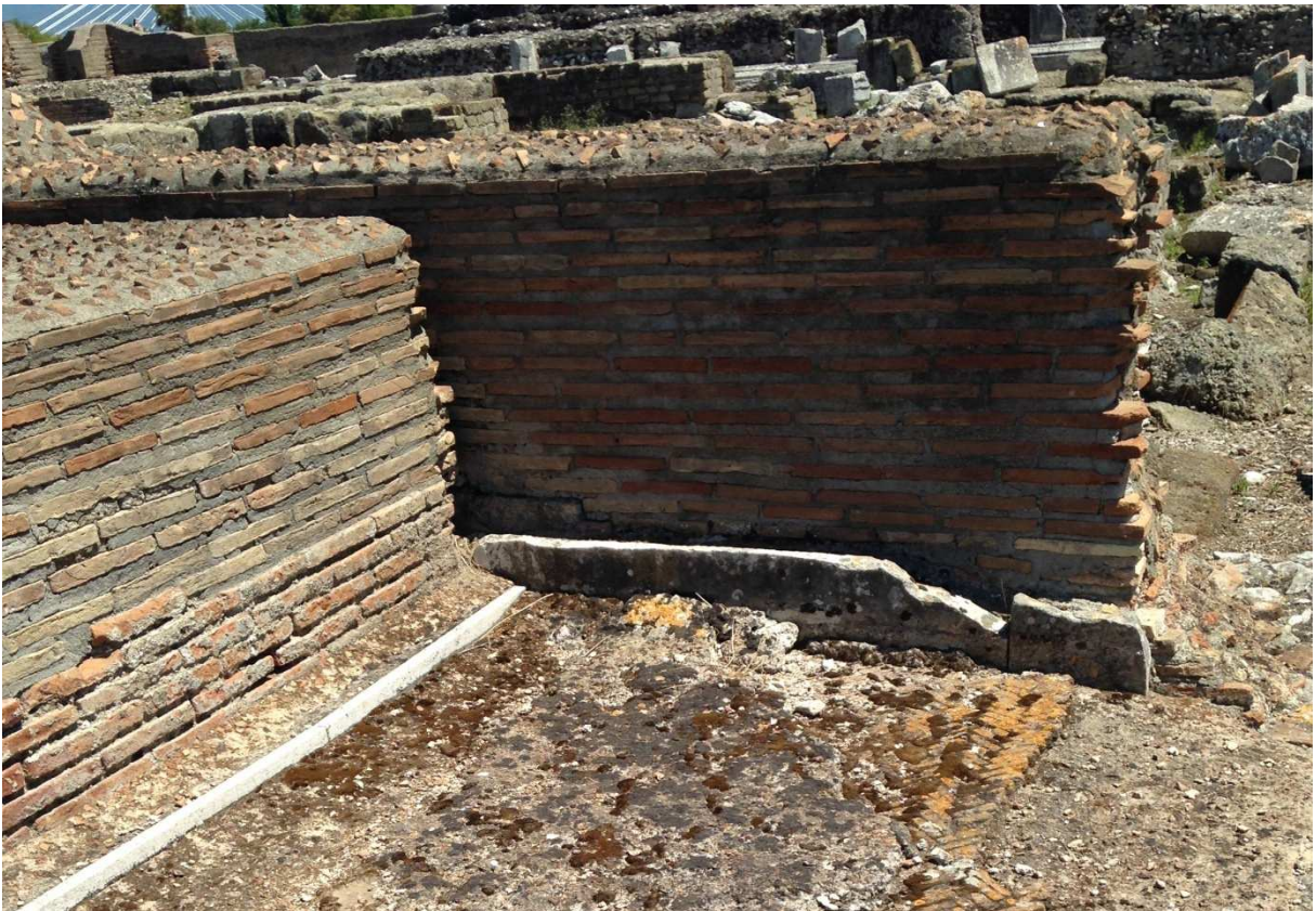
Figura 98: muro perimetrale est, facciata interna. Ninfeo Ovest - Minturnae.
