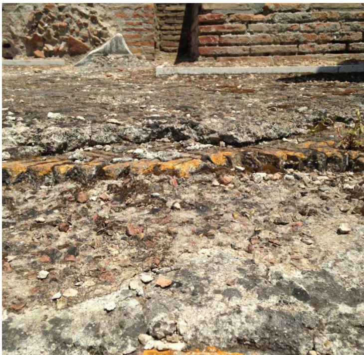
Figura 111: dettaglio stratigrafia pavimentazione vano antistante. Ninfeo Ovest - Minturnae.
