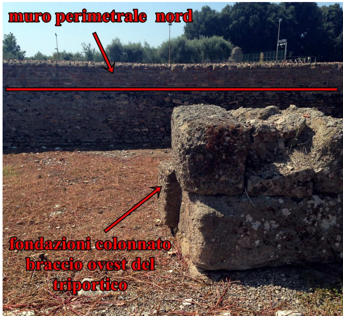
Figura 97: muro perimetrale nord, facciata esterna. Ninfeo Ovest - Minturnae.
