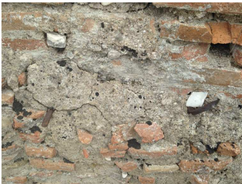
Figura 79: dettaglio grappe paramento marmoreo abside. Ninfeo Est - Minturnae.
