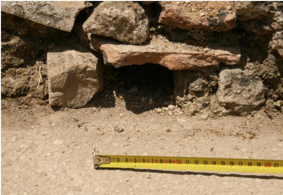
Foto 14: Bocca del canale in basso a sinistra della parete centrale, lato sud.
