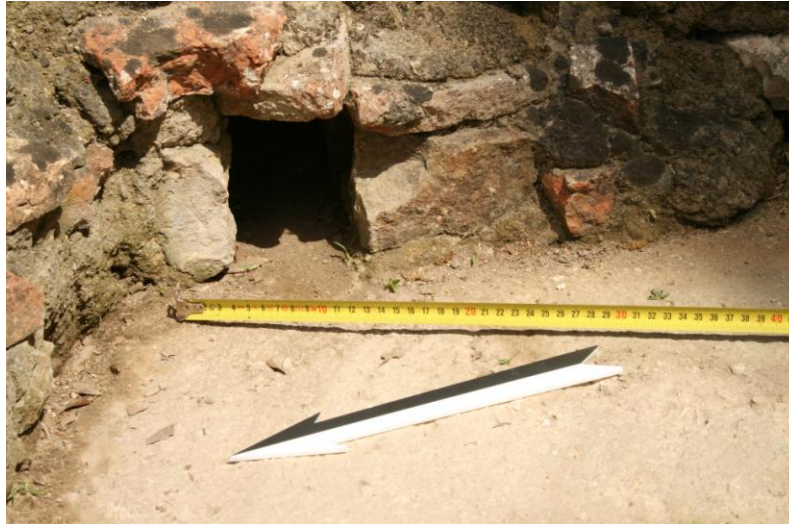
Foto 5: Particolare foro lato destro della parete centrale.
