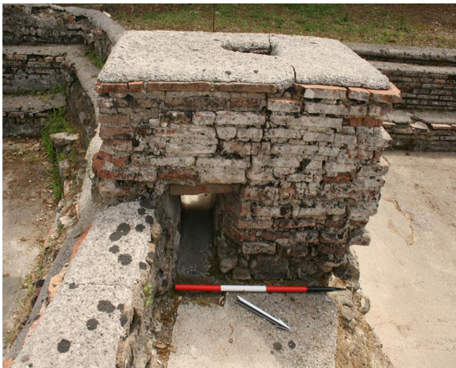
Foto 8: Particolare lato sinistro “Torretta” centrale.
