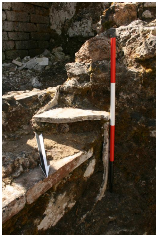
Foto 33: Particolare del rivestimento in marmo del gradino lato est
