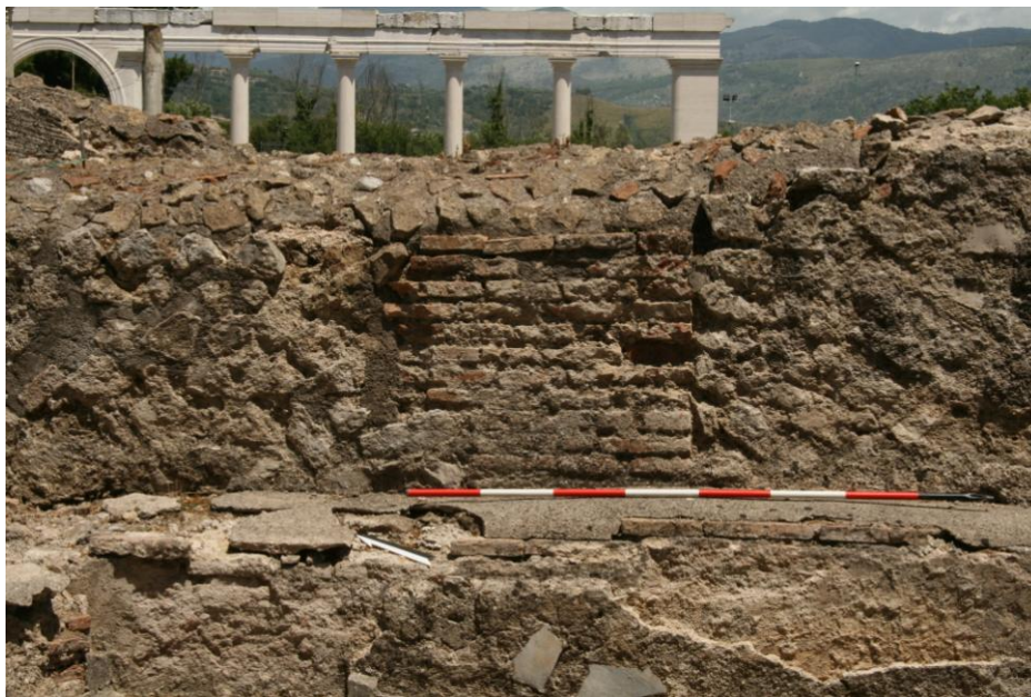
Foto 44: Riempimento in laterizio muro perimetrale della natatio lato nord.
