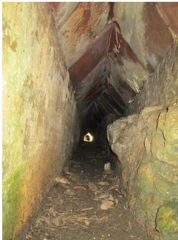
Foto 59: Interno della fogna “a cappuccina” che percorre il muro perimetrale della natatio .
