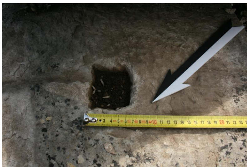
Foto 53: Particolare del blocco in marmo di fondazione della colonna parete est
